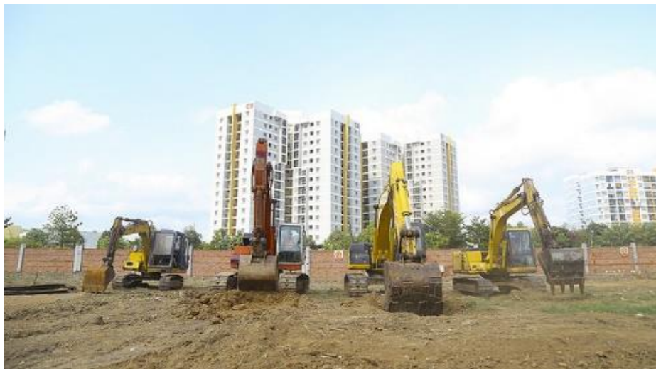
ศูนย์จัดเก็บข้อมูลดิจิทัลแห่งแรกขนาดใหญ่ที่สุดของเวียดนามเริ่มการก่อสร้างแล้ว ณ ไฮจิมีนห์ Hi-Tech Park
